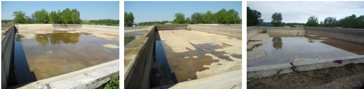
Abbildung 7. Grundriss der ehemaligen Feuerlöschbecken des incampus (oben) und ihr aktueller Zustand (A, B, C unten von links nach rechts).
